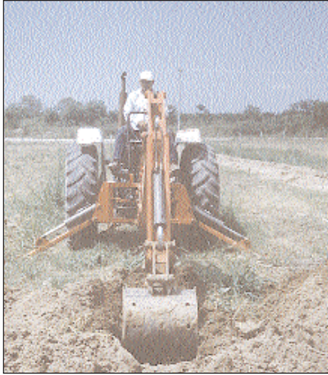
Inicio de la excavación de una zanja para tubería de riego.
