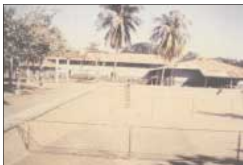
Instalaciones del ahora centro de Comunicaciones de la FHIA, en 1985.
